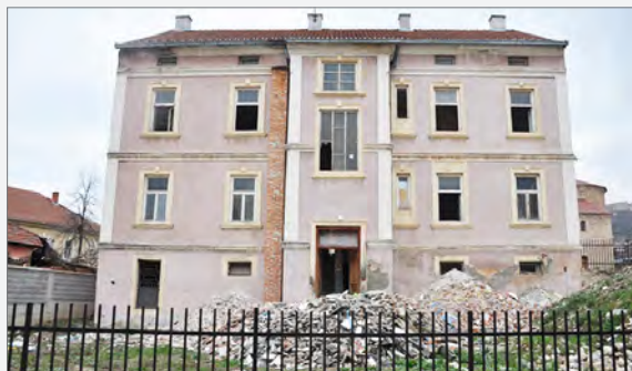
Das Caritas-Haus wird entkernt und der Schuttberg davor wächst täglich
